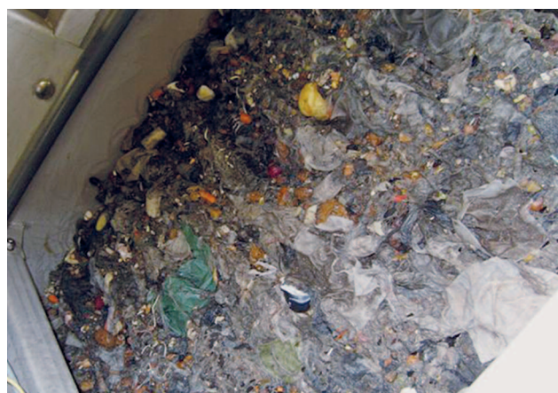
STEP SCREEN® 阶梯格栅: 通过细小栅距和产生的栅渣地毯可以确保栅渣分离效率, 动栅片组件的转动使得过滤栅网具有自清理功能。
