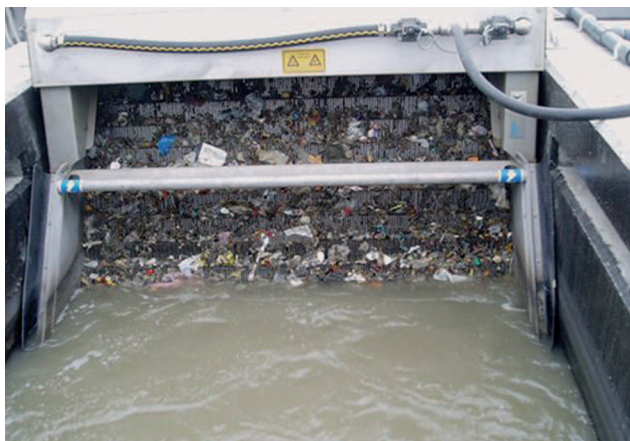
STEP SCREEN® 梯形格栅SSF: 长度3.500, 宽度 1826, 栅距 6 mm, 安装角度50°。因为一次性穿流栅网, 格栅过水能力很强。
