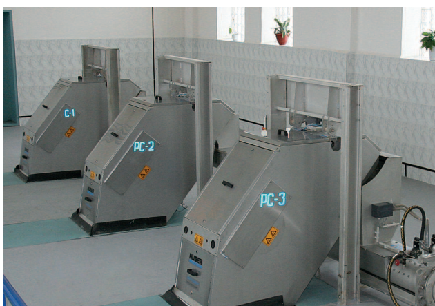
STEP SCREEN® 阶梯格栅在俄罗斯的应用: 格栅可在水渠内摇拽取出, 此时毋需拆卸后安装的HUBER 栅渣洗涤压榨机或运输螺杆。
