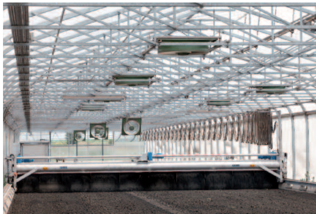
污泥翻滚机在暖房中工作
