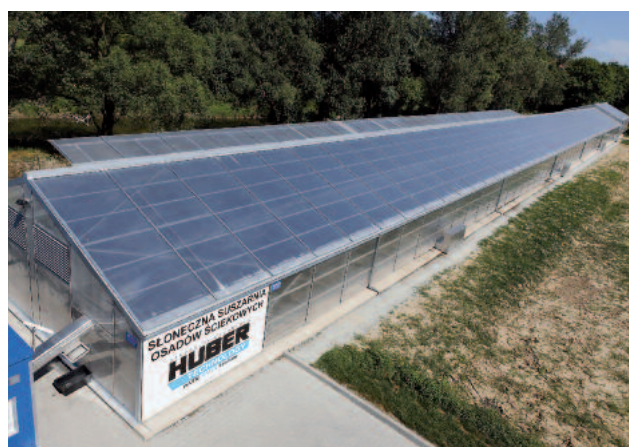
配置有屋顶天窗和气象站的干化暖房
