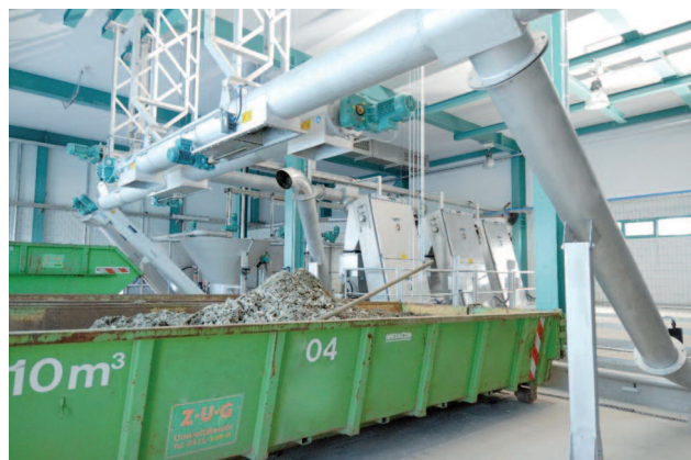
HUBER ROTAMAT® 管型运输螺杆进行栅渣排料
