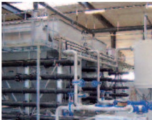
HUBER HDF 型减压气浮装置配置化学处理工段
