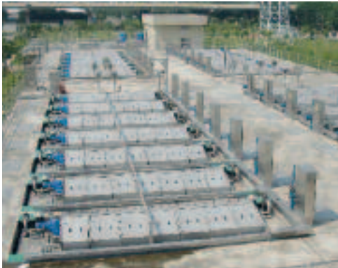
RoDisc® 转盘过滤器最大规格配置 30 张过滤转盘
