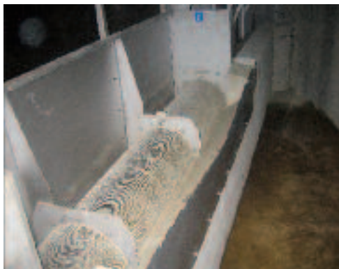
用ROTAMAT® RoK2型初期雨水/混合污水 过滤装置和测量堰测定排放流量
