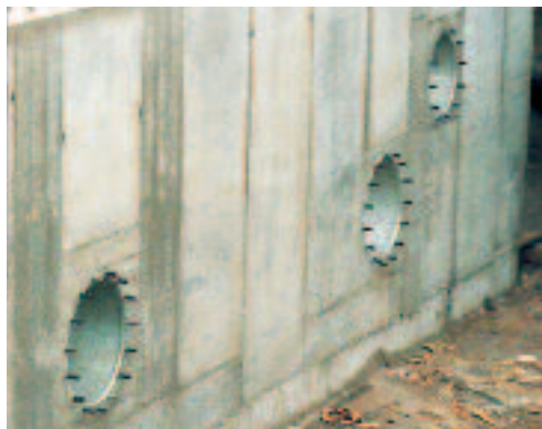
浇筑后的穿墙管
