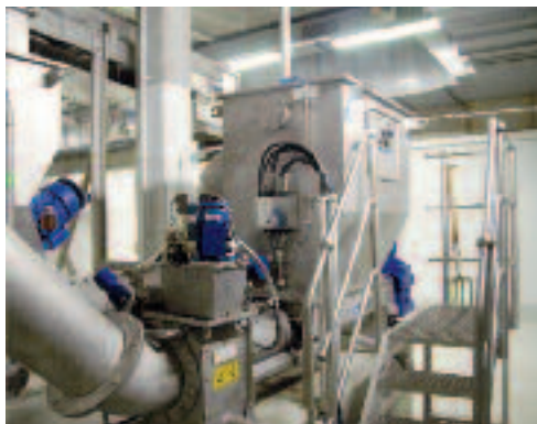
液压系统确保栅渣高固含率
