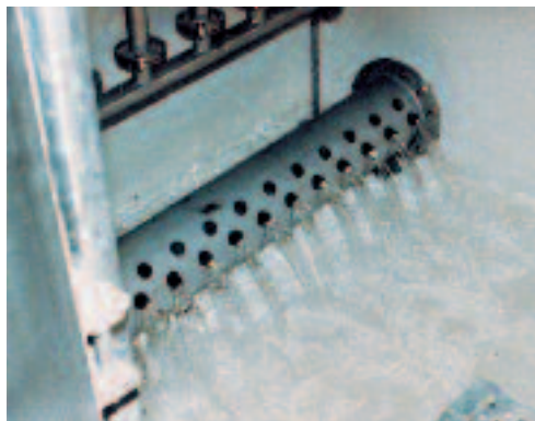
多孔进水管道
