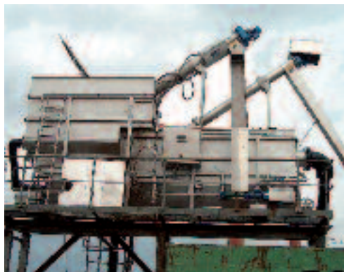
HUBER ROTAMAT® Ro5K一体式固液分离装置 配置1mm栅距过滤机
