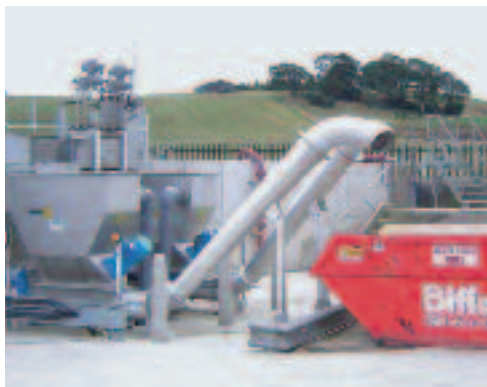
WAP/SL型滤渣冲洗压榨机, 保证最高洗出率
