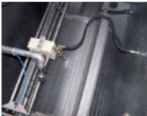
HUBER ROTAMAT® Ro 2型1 mm栅距细格栅 配置高压冲洗装置
