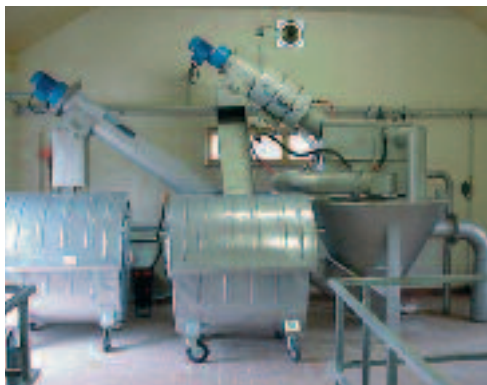
适用于小型污水处理设备厂的污水机械预处理设备
