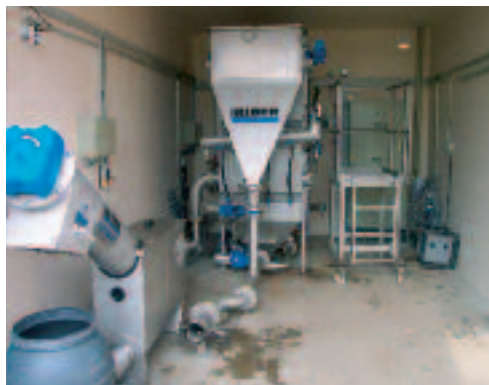
HUBER ROTAMAT® 1 mm 栅距螺杆过滤机与 HUBER HDF减压气浮结合使用
