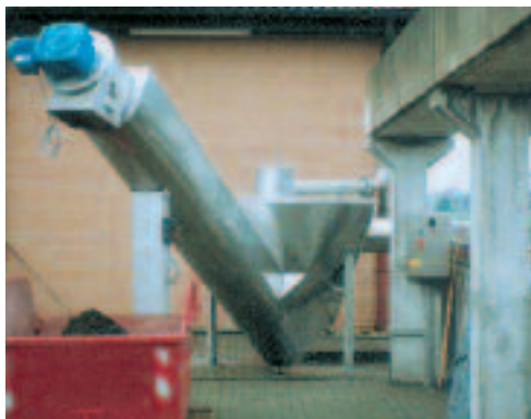
安装在沉砂池后的COANDA RoSF 3型砂水分离器
