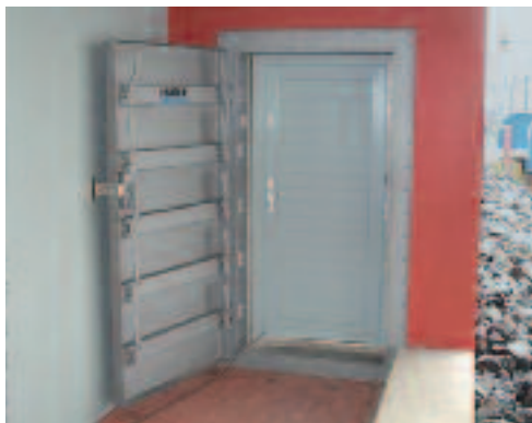
高压门可防止洪水
