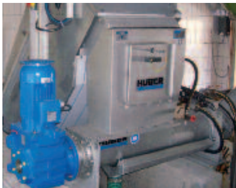
安装在阶梯格栅 STEP SCREEN® 之后的滤渣冲洗压榨机 HUBER WAP
