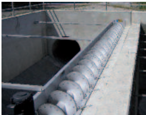
RoK 1: 安装在溢流堰后的雨水/合流污水过滤装置
