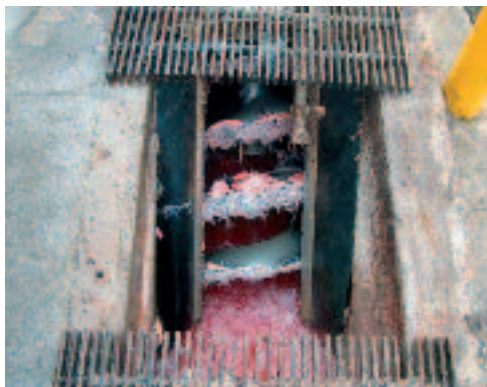
HUBER ROTAMAT® 螺杆过滤机Ro9, 3 mm过滤孔径
