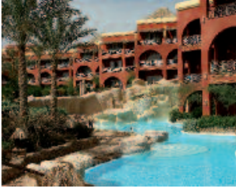
工程实例：一酒店使用HUBER BioMem® 膜滤系统进行污水再利用
