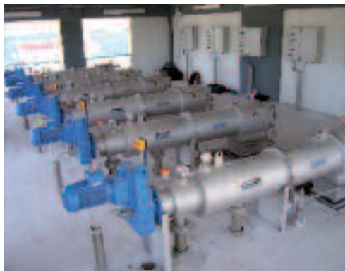
STRAINPRESS® – 压力条件下连续的粗体物质分离
