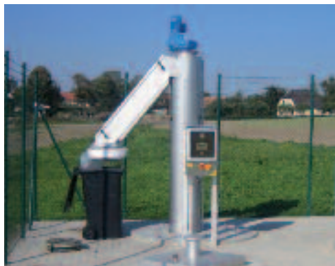
室外安装的污水井过滤机械RoK4,配置防冻装置
