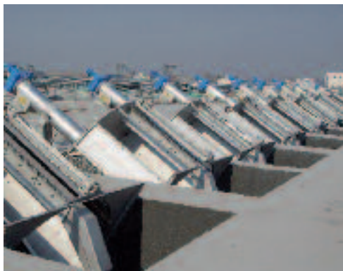
ROTAMAT® 细格栅 Ro 1 可安装在水渠或箱体中
