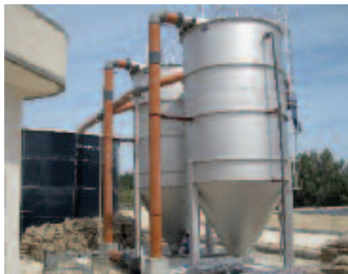
CONTIFLOW® 砂滤装置，不锈钢箱体型
