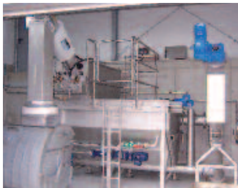
Ro 5HD-型一体化分离装置：在最小的空间内实现机械污水处理
