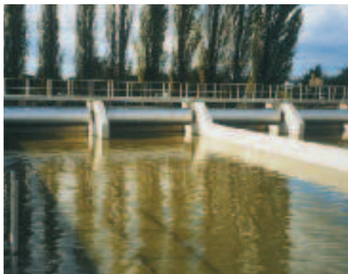
通过高效的冲洗系统进行可靠的池体清洗
