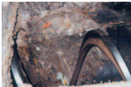
未经冲洗处理的滤渣
